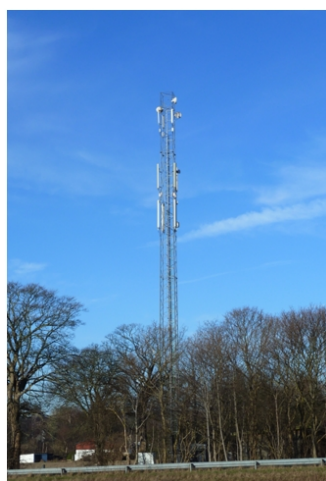
Masten er af typen gittermast som set på billedet til venstre. Masten laves i galvaniseret stål. Masten er 36 meter høj.
