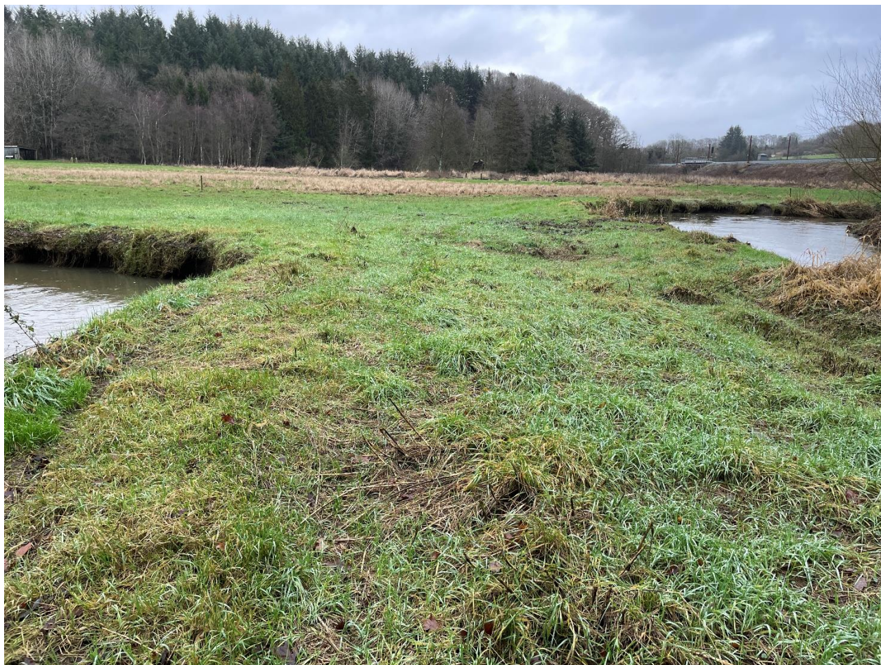
Foto af lokation for omlægning. 3 rør graves midlertidigt ned og tillader vandløbet at strømme på tværs fra venstre mod højre på billedet.
