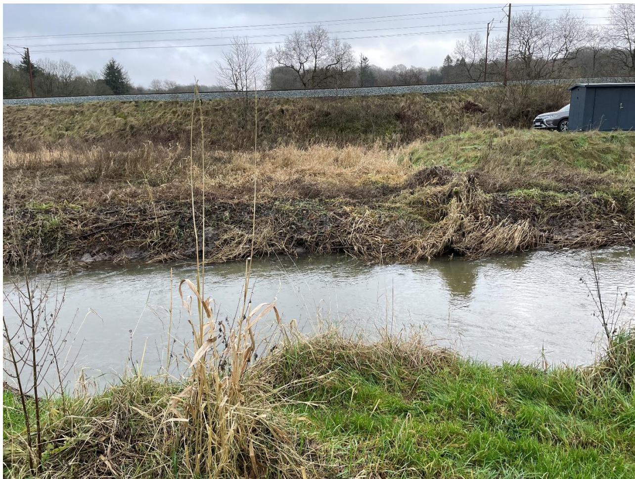
Foto af lokation for overkørsel.
