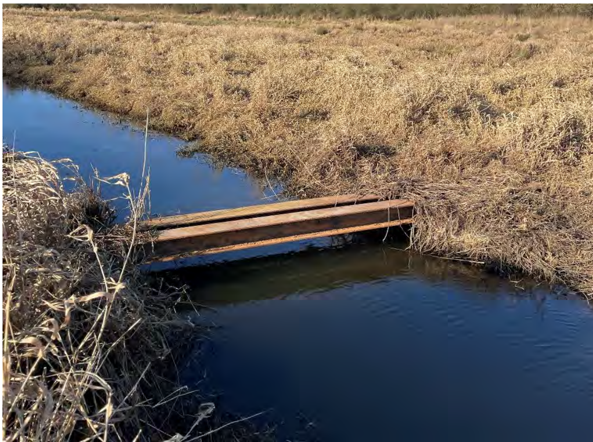
Figur 3-13 Eksisterende spang i vandløbet
