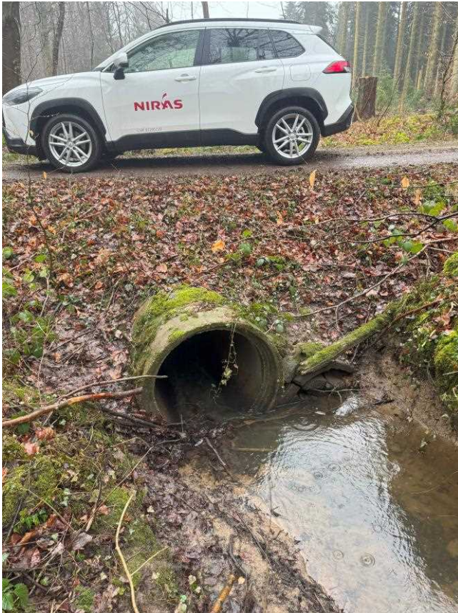
Figur 2.8: Billeder af rørunderføring ved strækning A (til venstre), hvor der skal foretages en bundhævning, samt udløbsbygværket ved strækning B (til højre).
