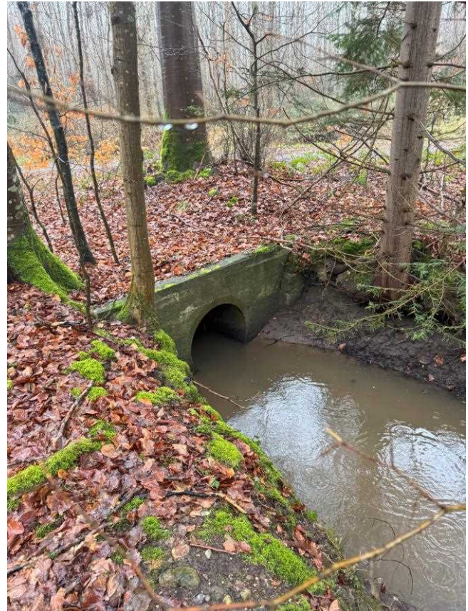
Figur 2.8: Billeder af rørunderføring ved strækning A (til venstre), hvor der skal foretages en bundhævning, samt udløbsbygværket ved strækning B (til højre).
