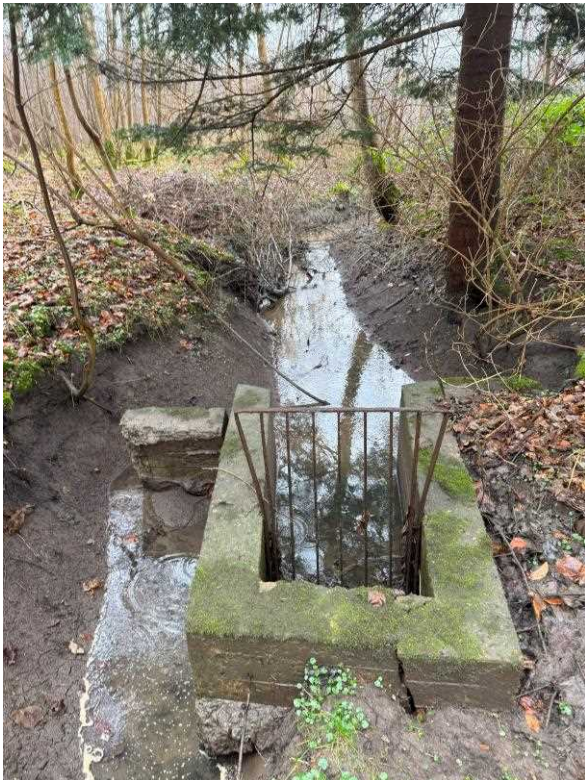
Figur 2.5: Indløbsbygværk (til venstre) og samlebrønd (til højre) ved strækning 1.
