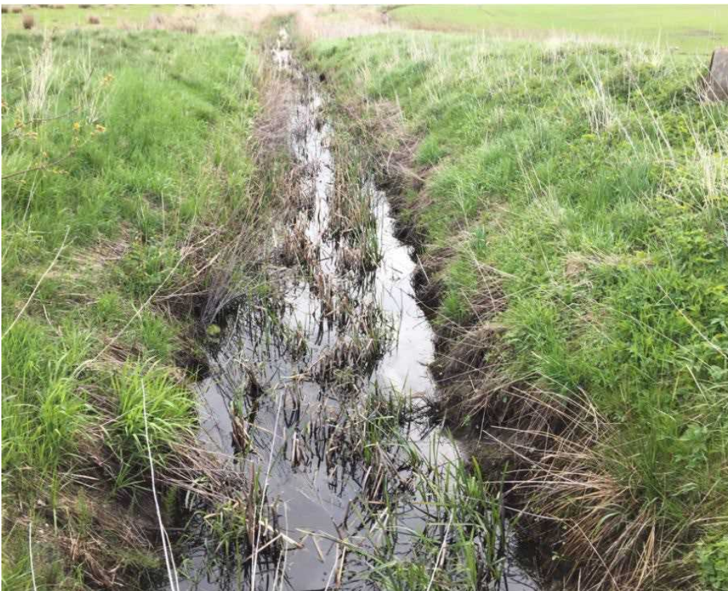
Figur 3. På delstrækning 1, den øvre del med fald under 0,1 ‰, og ringe vandbevægelse
