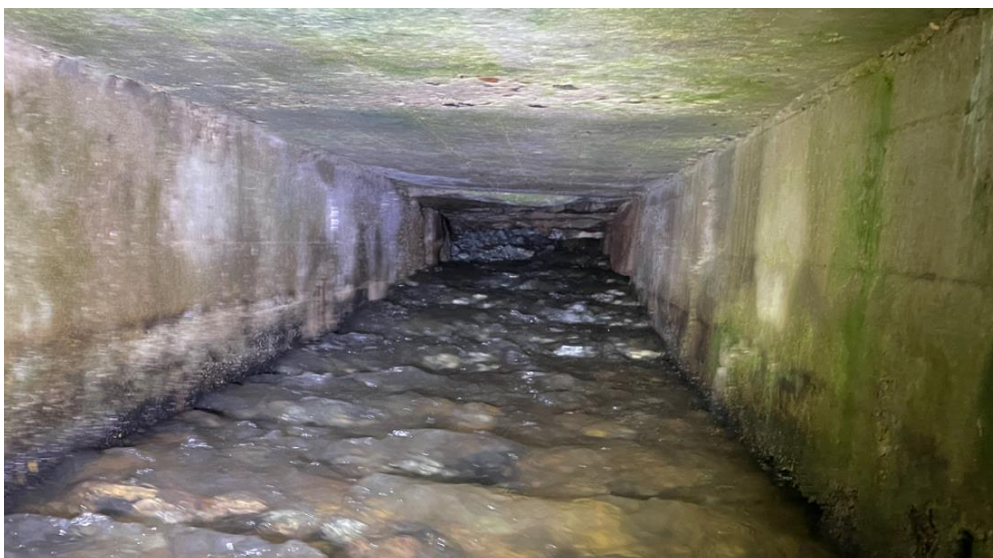
Figur 3 Materiale fra dæmningen i stenkisten
