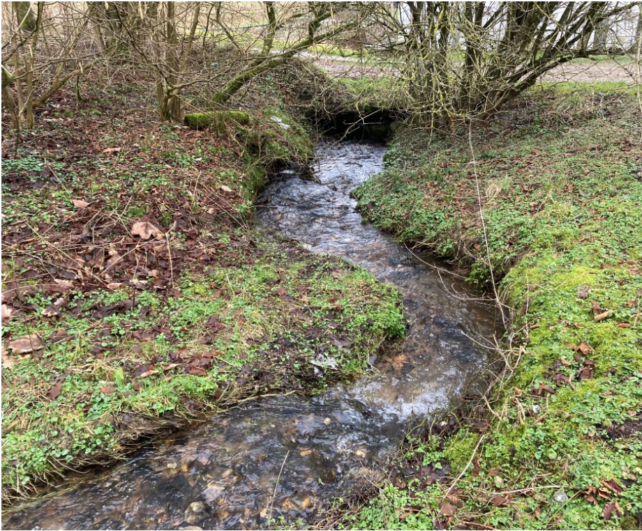
Figur 2. Umiddelbart opstrøms for indløb til røroverkørslen
