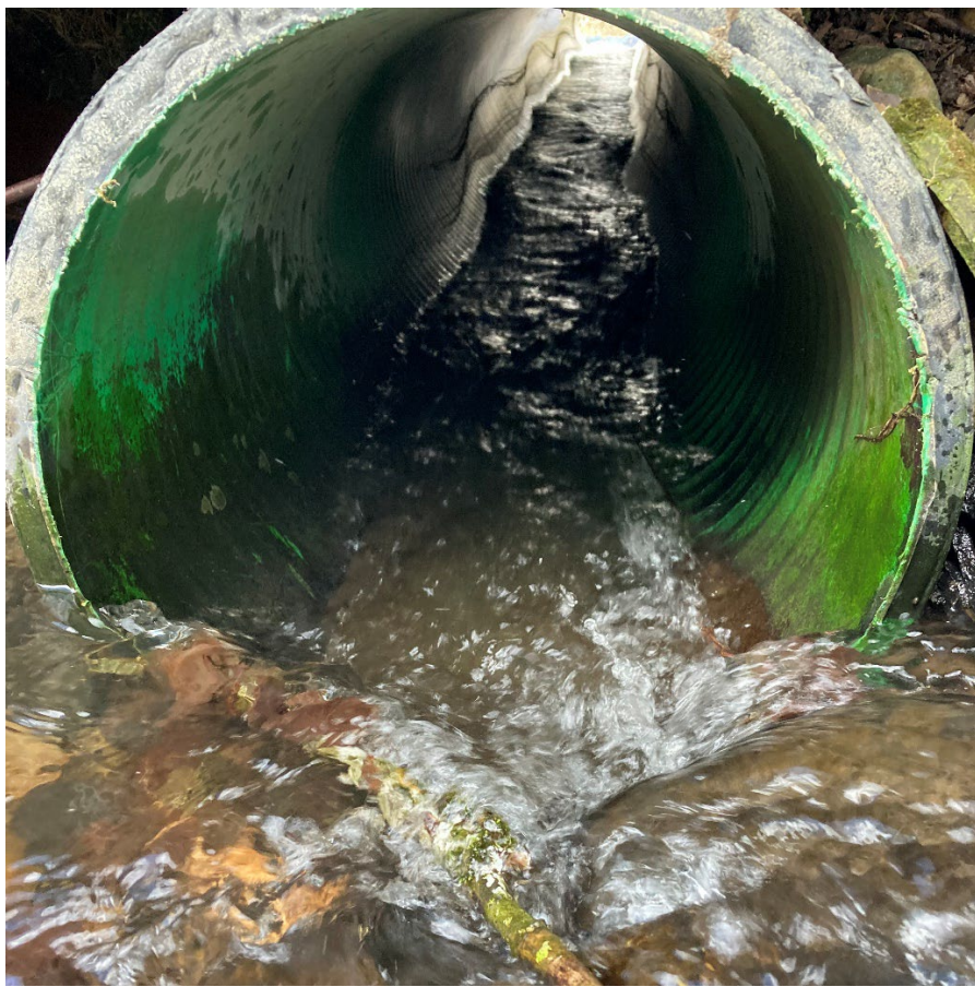
Figur 4. Fald ved indløb i røroverkørslen
