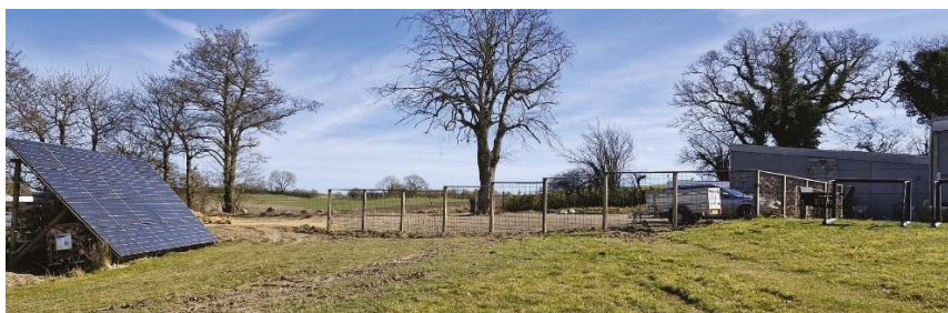
Det opstillede solcelleanlæg set mod øst, jf. ansøgningen
