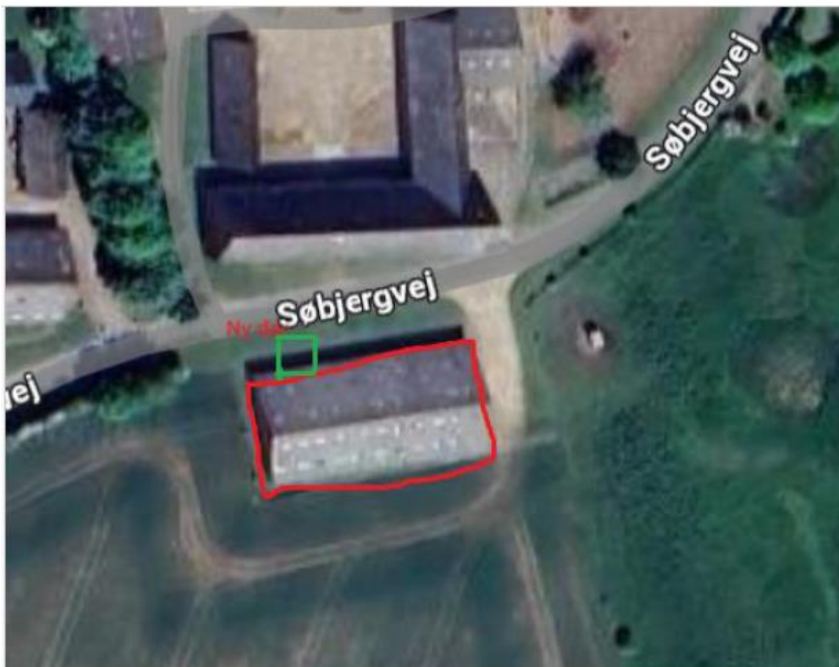
Luftfoto med angivelse af maskinhuset, der ændrer anvendelse til ridehal, jf. ansøgningen.
