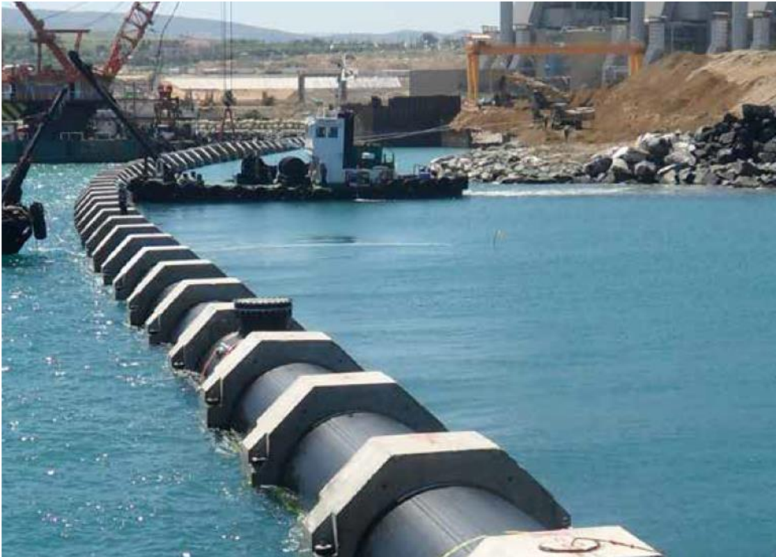
Figur 4. Eksempel på stor PEH ledning med balastklodser (Pipelife.com)
