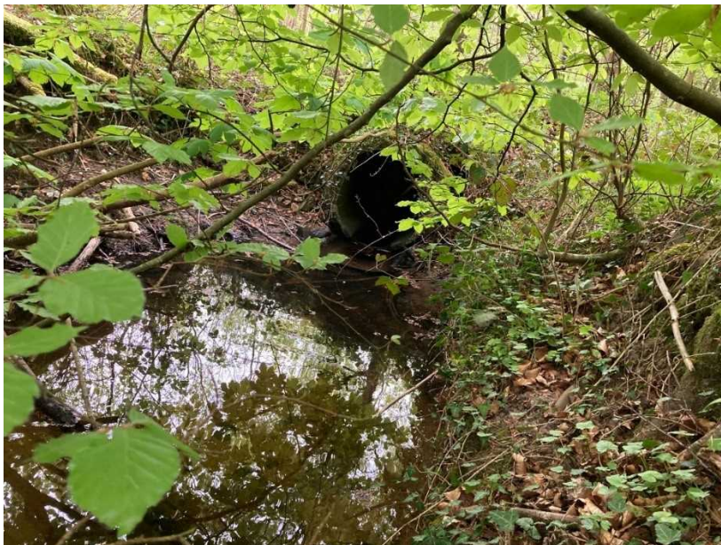
Figur 3-9 Rørbro ved Grønnevej.
