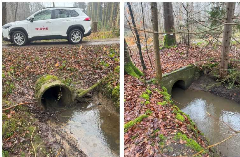
Figur 7: Billeder af rørunderføringen ved strækning A (til venstre), hvor der skal foretages en bundhævning, samt udløbsbygværk ved strækning B (til højre)
