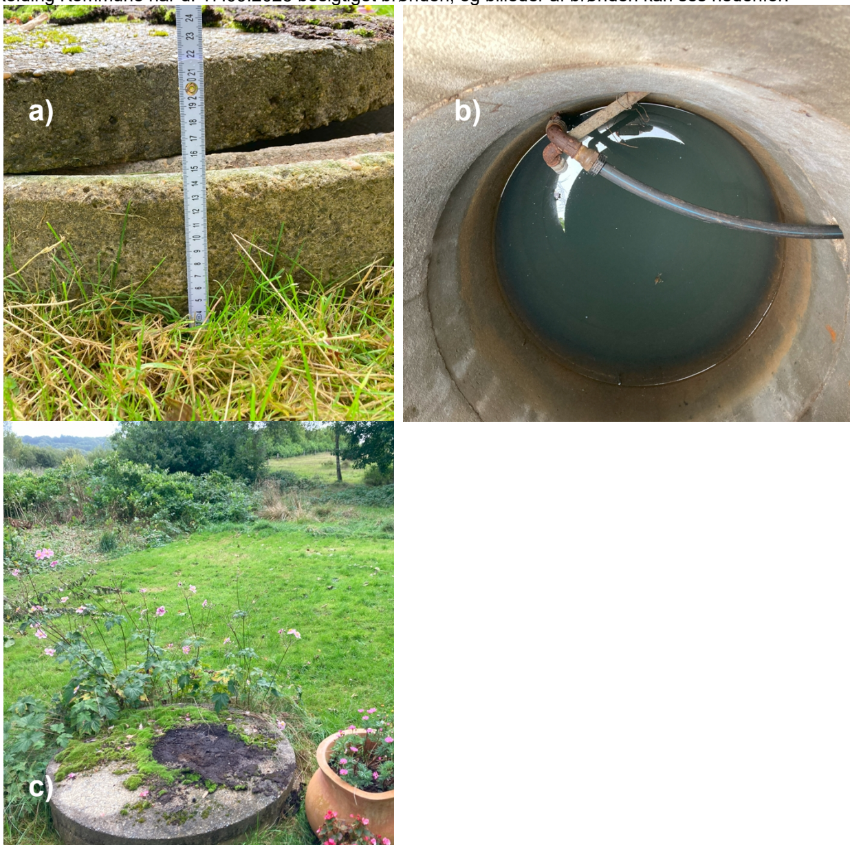
Figur 3: placeringen af brønden set fra 3 forskellige vinkler. a) Brøndens højde over terræn, ca. 14 cm, b) indersiden af brønden, c) brøndens placering på grunden
