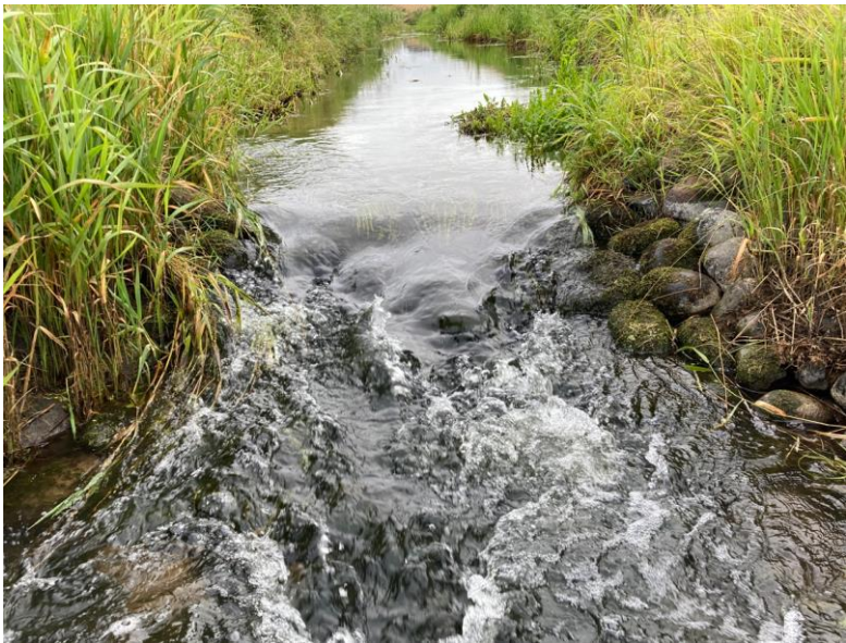
Figur 2: Styrt ved st. 13.010 m
