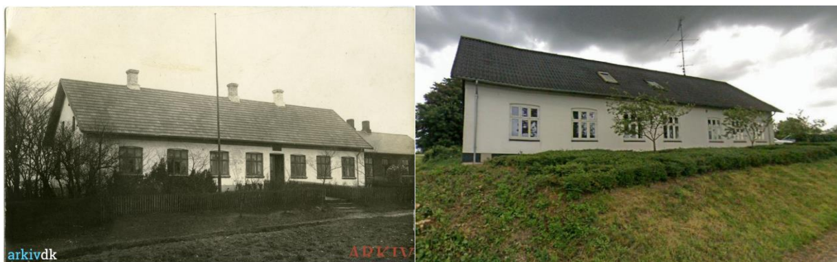
Foto fra 1919 hhv. gadefoto fra 2020 af den tidligere rytterskolebygning i Vrå
