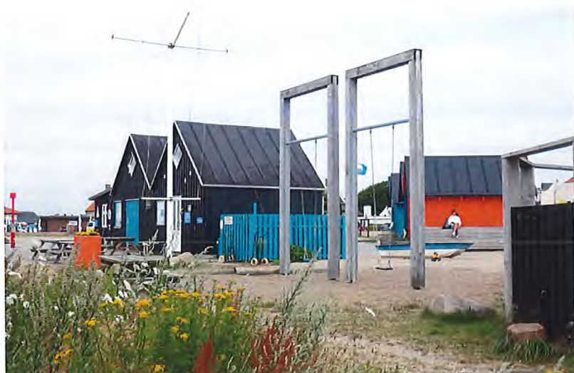
De nye træhuse med fællesfaciliteter og de nye udearealet har forbedret havnen, og der er planer og ønsker om mere.
