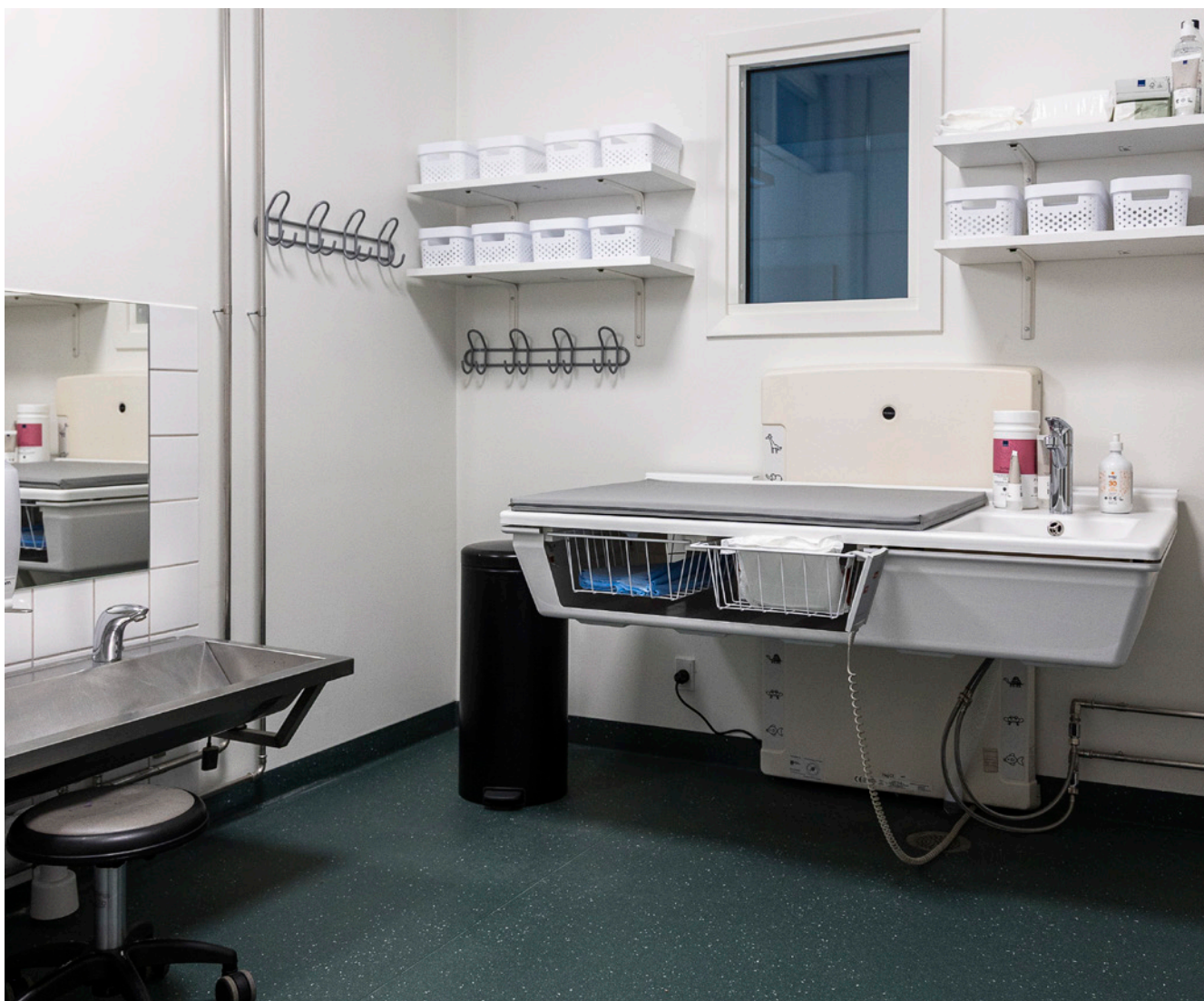
Børnehuset Vingesuset, afd. Riis Toft: I ombygningen af den eksisterende børnehave til en integreret daginstitution med vuggestue, har der været fokus på at genanvende mest muligt. Toiletrummet blev indrettet til puslerum med pusleborde bestående af en genanvendt konsol, fra en anden institution, der er blevet repareret og en ny bordplade. Vaske og toiletter er også genanvendte.
